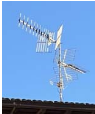
Rooftop UHF TV antennas.
